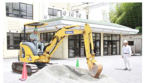
※ ショベルカーを操作している様子
